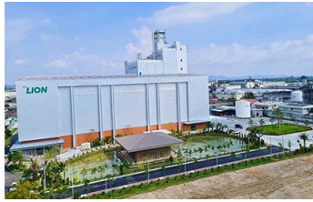
タイライオン新乾燥塔建屋の外観写真
